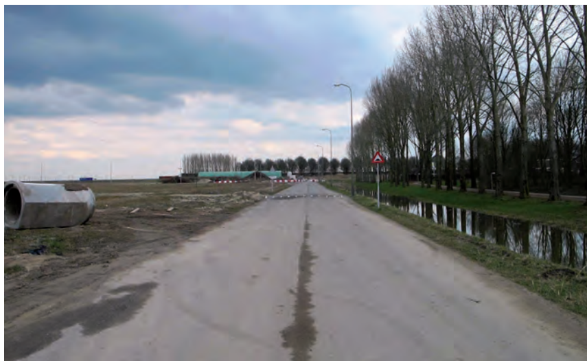
Tijdens de bijeenkomst worden bewoners en bedrijven langs het tracé van de HOV-baan – in de planning van de provincie Noord-Holland rechts van het 'stroompje' – om advies gevraagd. (Foto Stroomzijde richting A27)
