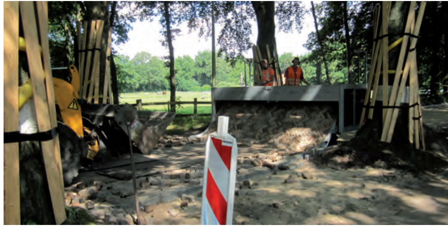
Herbestravingswerkzaamheden aan de Blaricummertollaan.
