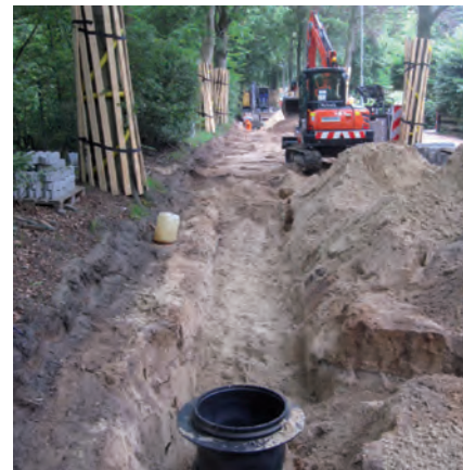
Vernieuwde riolering aan de Blaricummertollaan.
