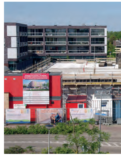
De bouw van De Balken vordert gestaag, mei 2015.
