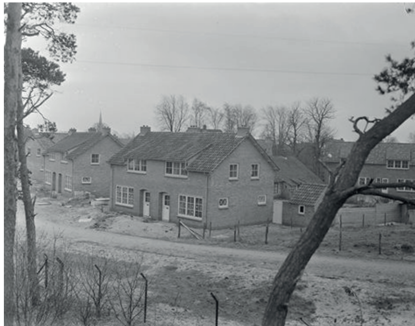
Woningen in aanbouw bij de Mosselweg
