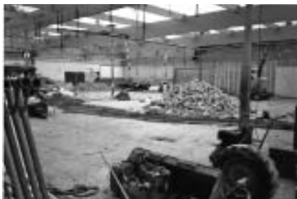
Tijdens de renovatie
