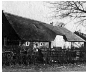
Het nieuwe rietdak boerderij (voorheen) Jan de Gooyer.
