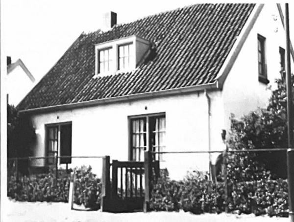
Eén van de afgebroken 'witte huisjes' aan de Eerste Molenweg.
