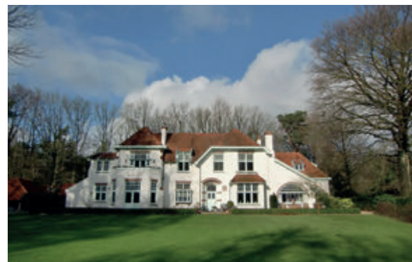
Villa Zonnehoef gebouwd in 1900 in Art Nouveau-stijl in opdracht van de vader van Lou. Lou beschreef later uitgebreid het interieur, het leven in de villa en haar atelier in de tuin.
